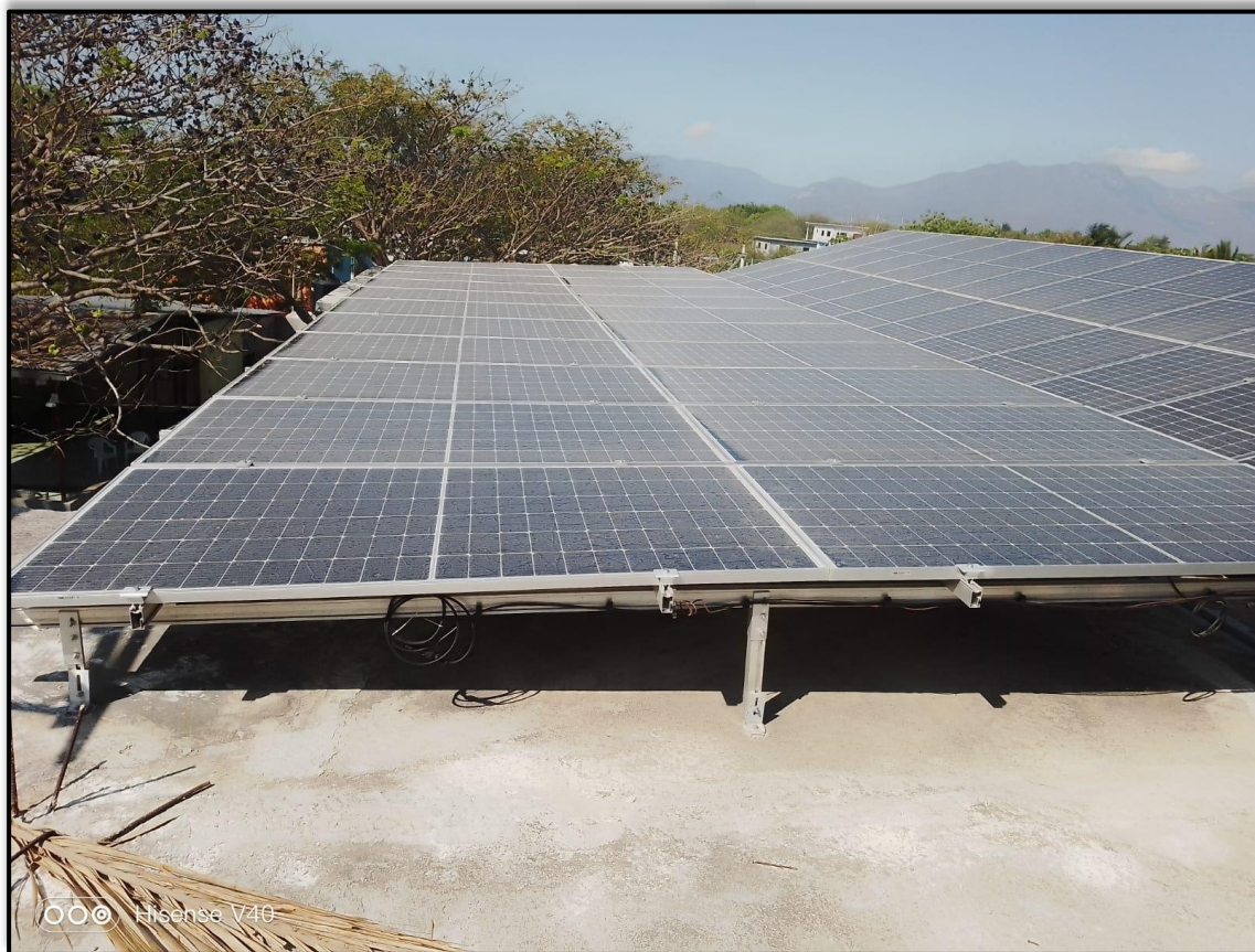
Ilustración 1. SFV Ixtepec – 2 arreglos de 11 cada 1 + 2 arreglos de 17 cada 1
