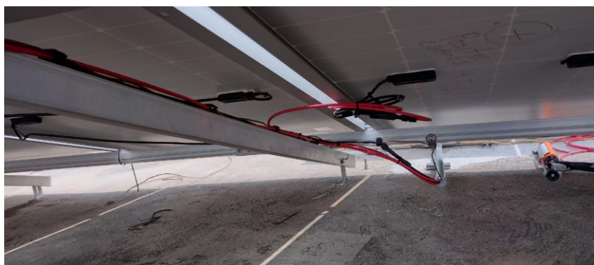
Detalles de conexiones eléctricas en Inversores 1 y 2
