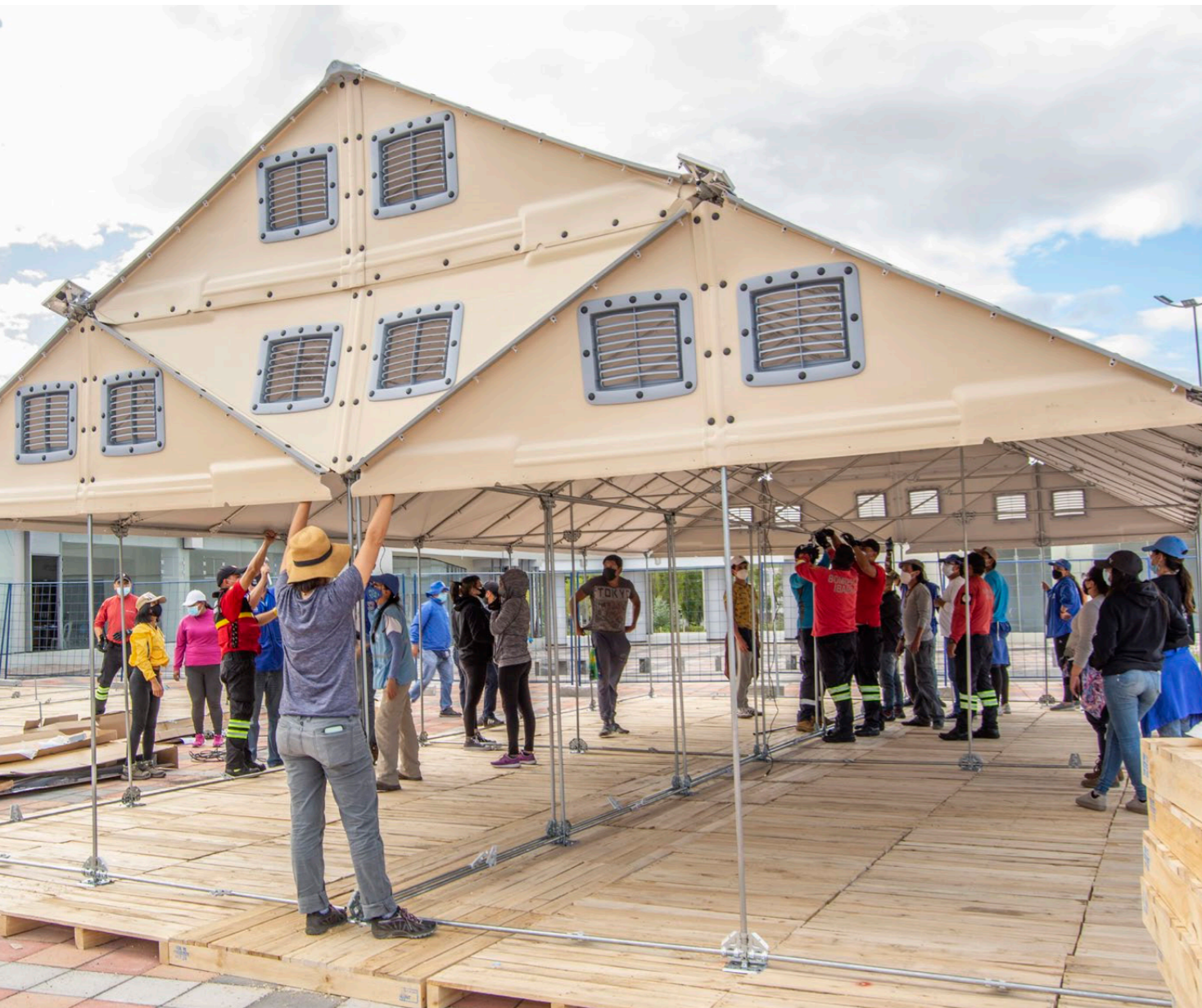
ACNUR, los socios y jóvenes voluntarios construyen unidades de vivienda para personas refugiadas para expandir un comedor comunitario en Ibarra, Ecuador. © ACNUR/ILARIA RAPIDO RAGOZZINO
